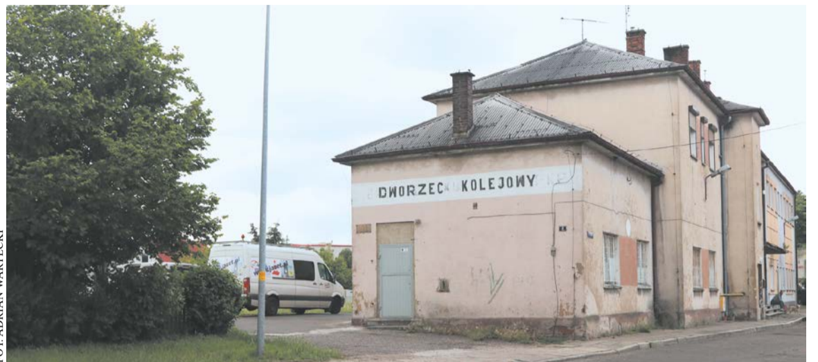
Tak dzisiaj wygląda budynek dworca w Śremie
